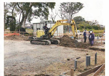
基礎工事の様子
